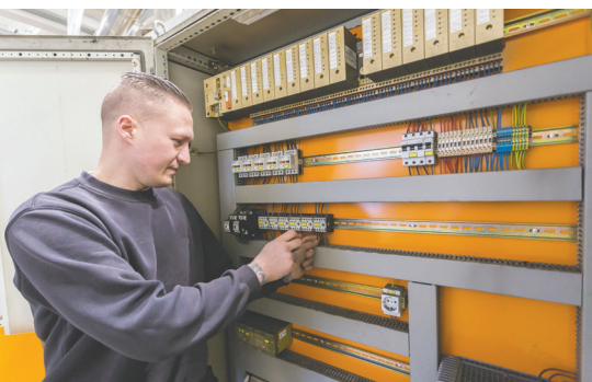
En af Strøm Hansens dygtige montører justerer en styretavle hos Baltic Packaging. Der skal i alt ca. 70 styretavler til på fabrikken.
