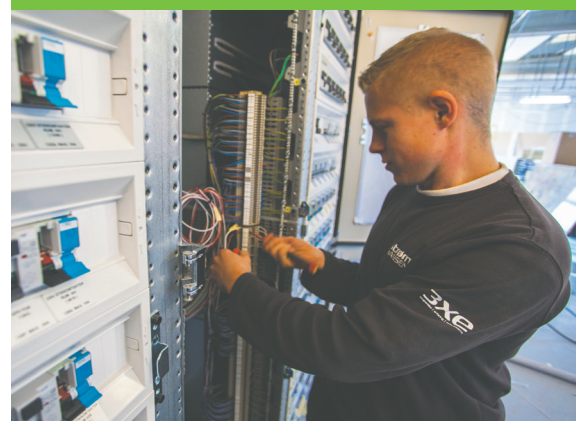
Tavle klargøres: Montage af kabler i kabelfelt
