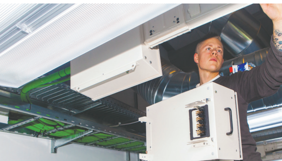
Tilslutningsboks til kanalskinner monteres, så arbejdsstationerne blot kan "klipses på"
