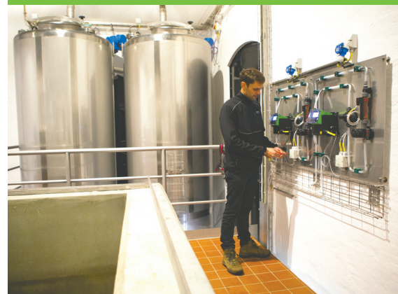
Montering af ludanlæg i det nye Gudenå Vandværk
