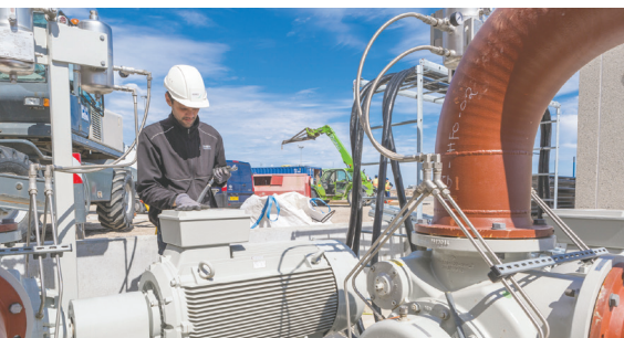
En af pumperne til det store anlæg monteres
