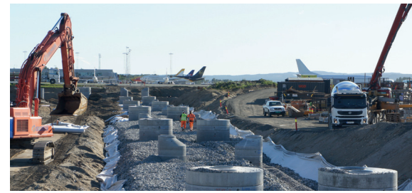
Der etableres kabeltrække-kummer samt kummer/brønde til det elektriske udstyr, der understøtter banelyset
