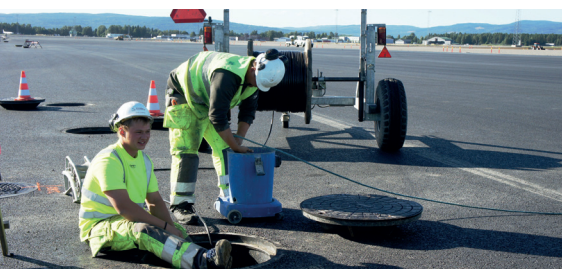
Der trækkes kabler; 210.000 meter i alt
