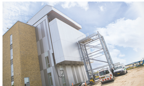
Endevæggen og taget over laboratoriet er hhv. sænket og løftet. Forrest ses elevatoren til testbilen
